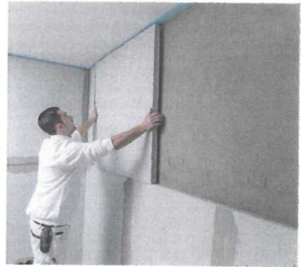
rechts: Innendämmung mit offenporigen, feuchteregulierenden Kalziumsilikatplatten. Isotec
